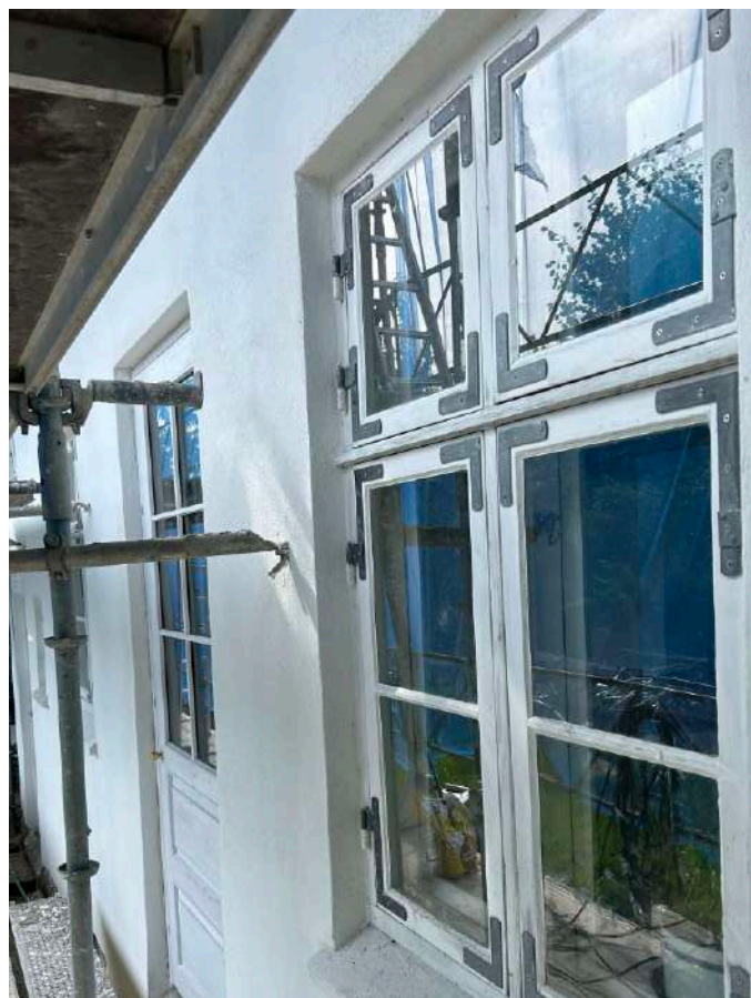
Efter udtørring blev alle flader påført hvid slutpuds
