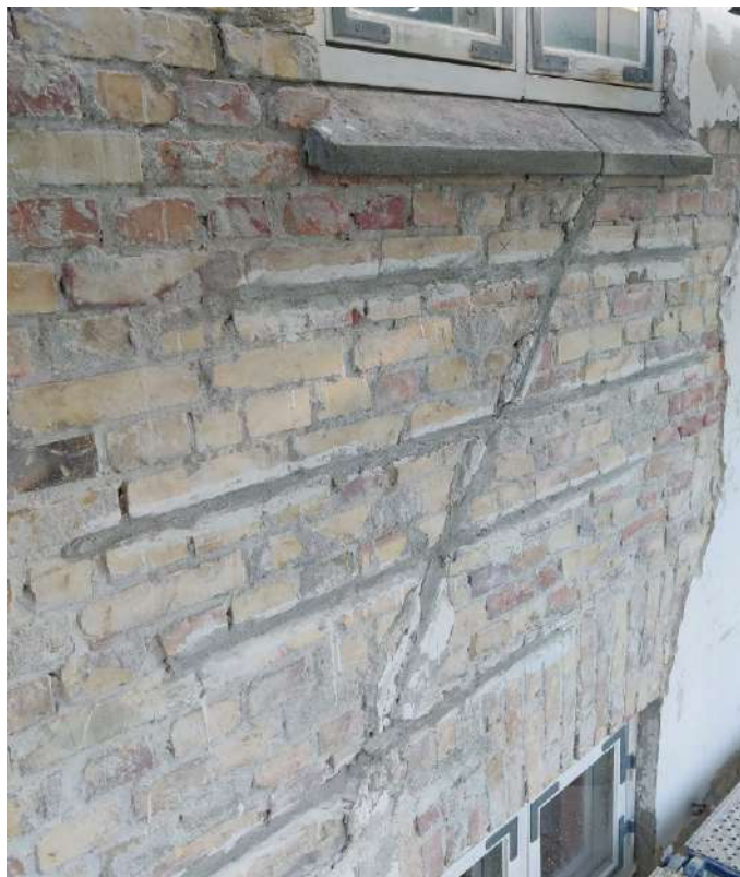
Nogle steder var det nødvendigt at forstærke murværker med indlæg af rustfrit armeringsstål
