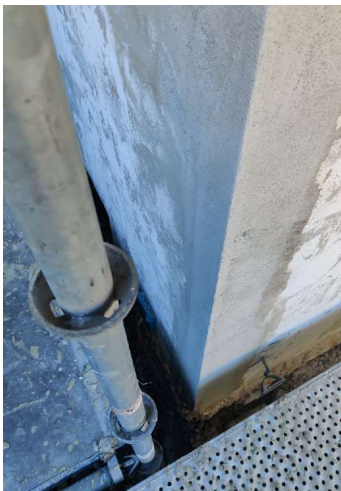
Alle hjørner inklusive kanter omkring vinduer blev forsynet med pudsprofiler således at alle står "skarpe"
