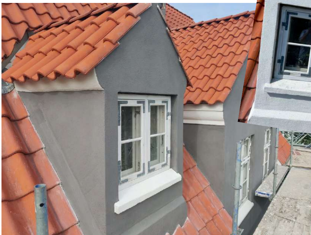
Den hvide slutpuds har nu fået 2 gang Weber silikatmaling nr 6502-B
