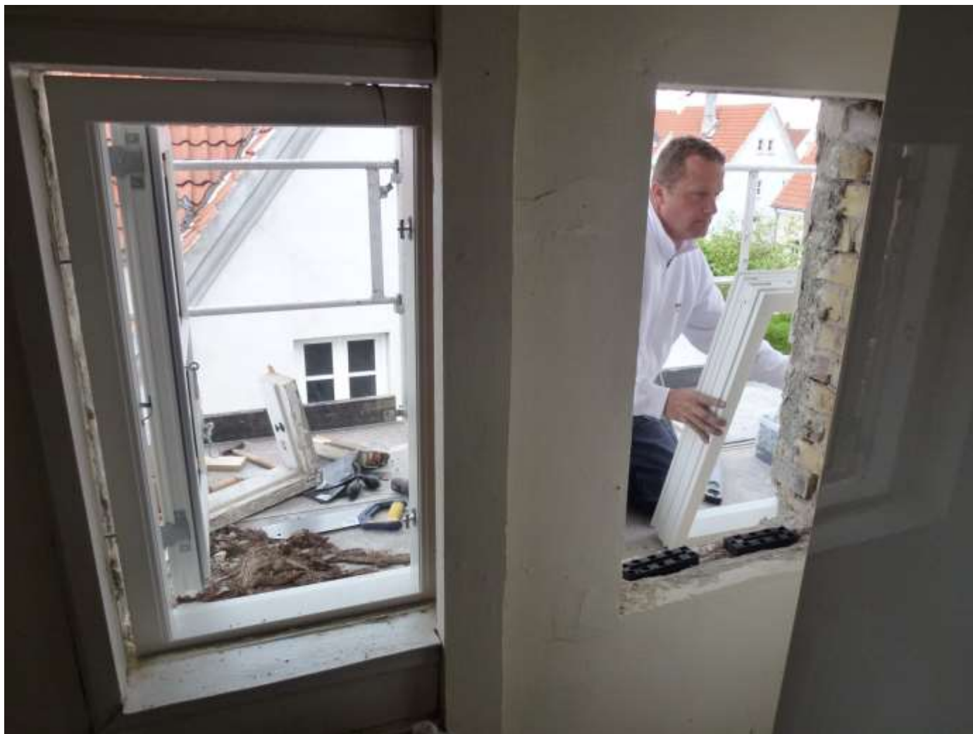
Foto: Udskiftning af de to vinduer øverst i gavlen over hoveddøren.
