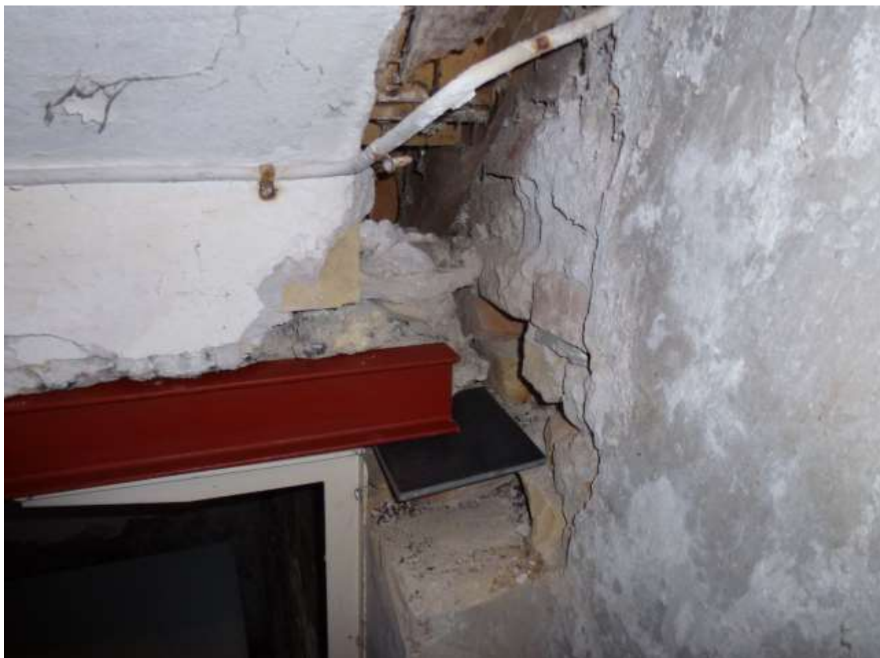
Foto: Nyt I-jern monteres under entre-pladen.
