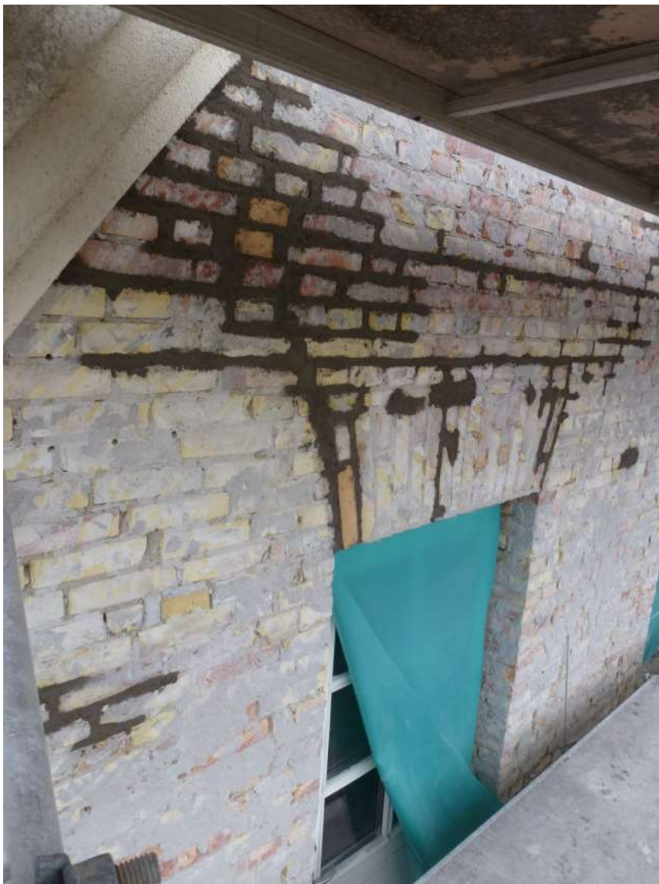
Foto: Fuger pudset op over altandør. Og nye mursten reparerer de bredeste revner.
