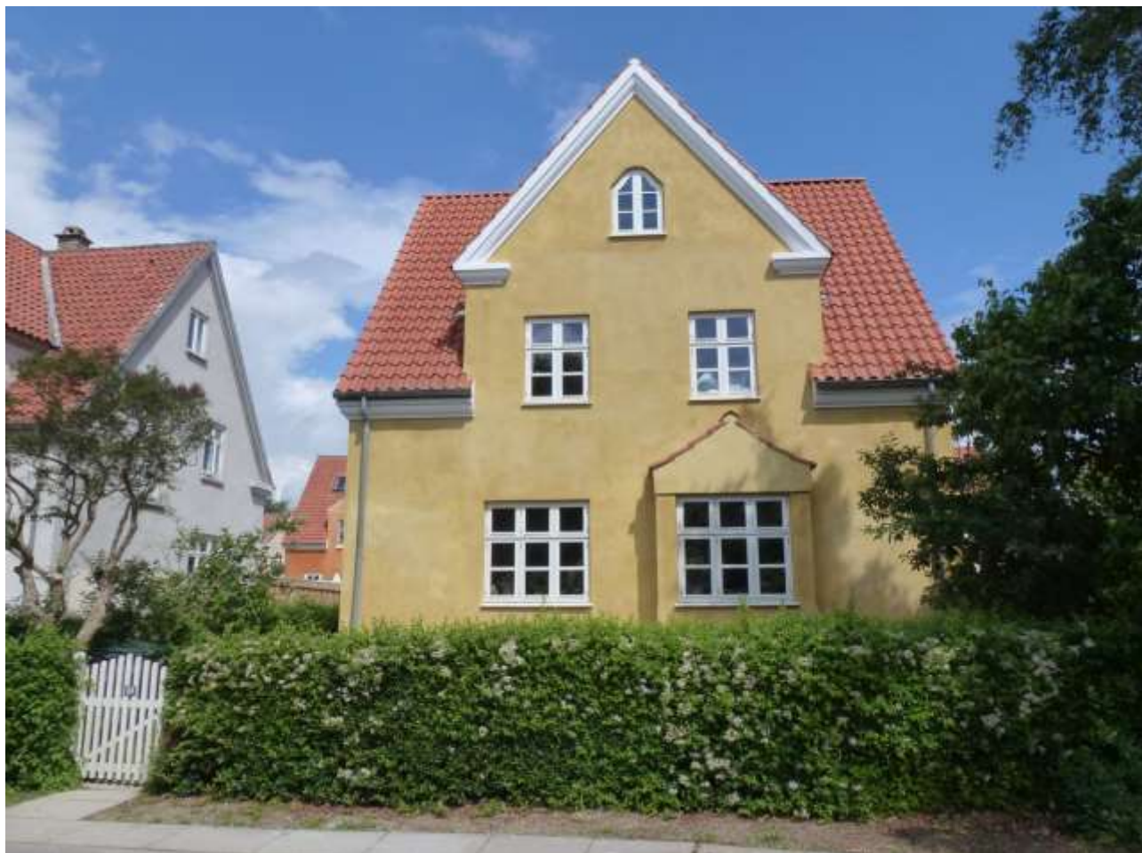
Foto: Facaden efter renoveringen
