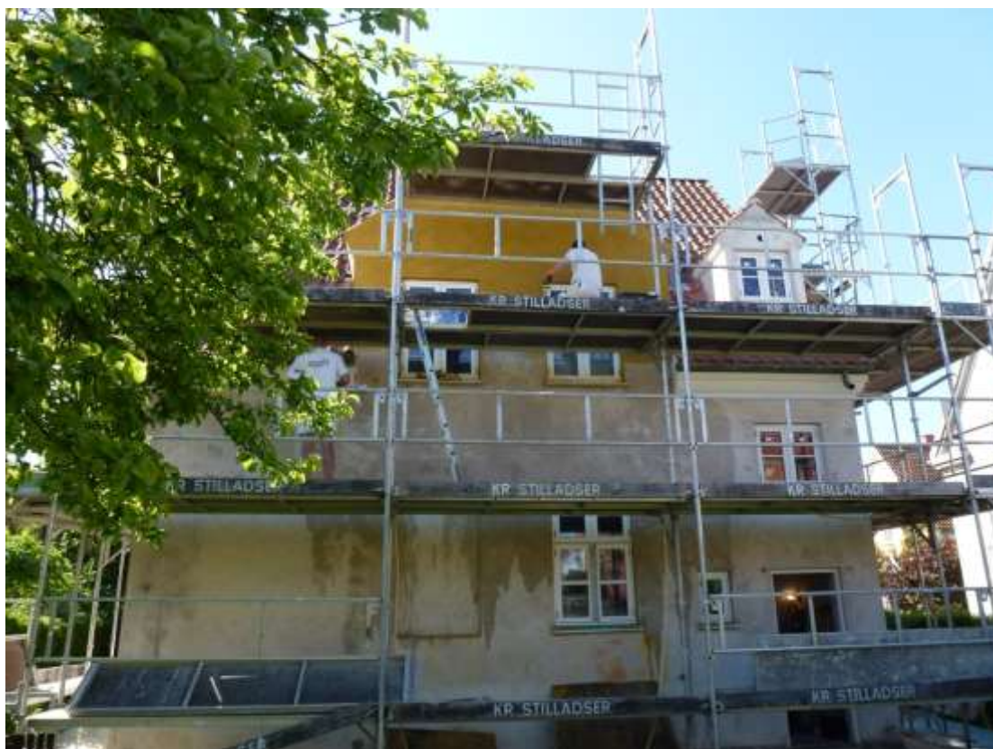
Foto: Der finpudses med oxidgul. Bemærk at muren fornedet mørkere, fordi den er gjort våd
